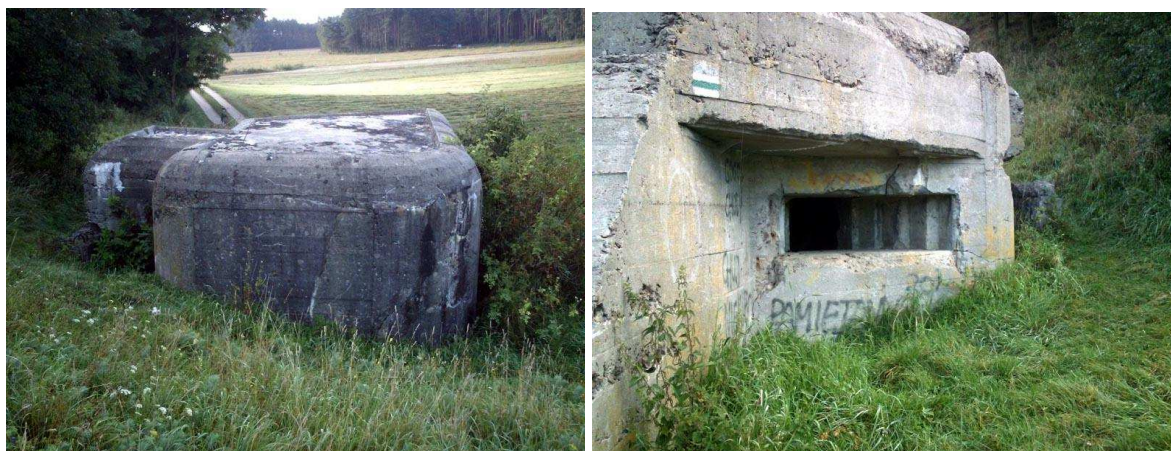
Rysunek 18. Bunkry na linii obrony Stońsko-Beleń
