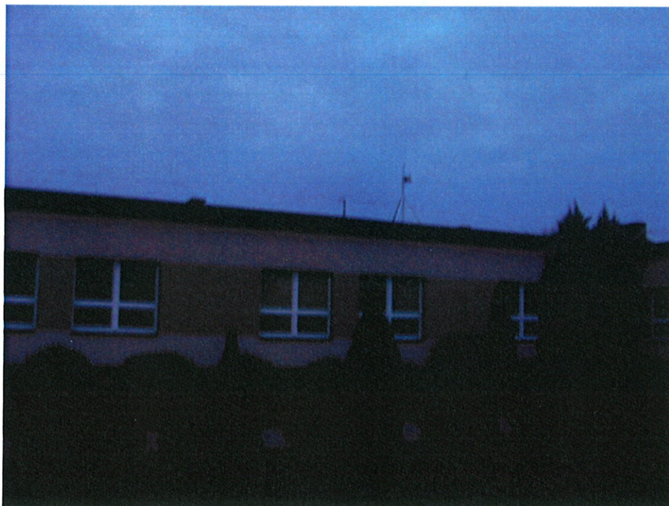
Fot. 1. OM Barczew 3 / Szkoła – widok anteny Emitel na dachu budynku
