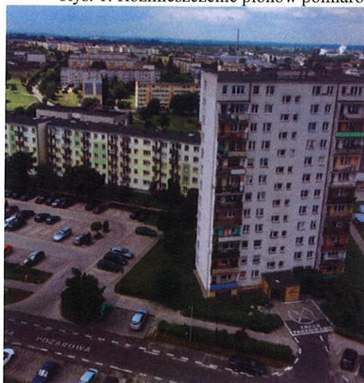
Fot.2 Widok na antenę sektorową na azymucie 285/295°
