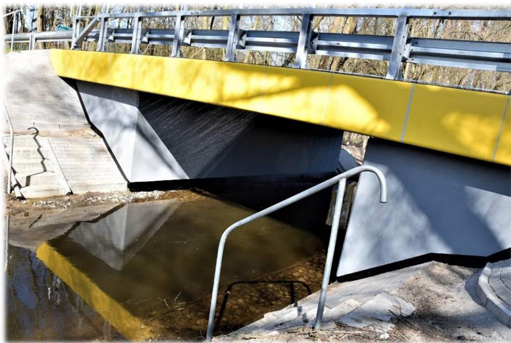
fot. budowa mostu na Kanale Tyczyńskim
