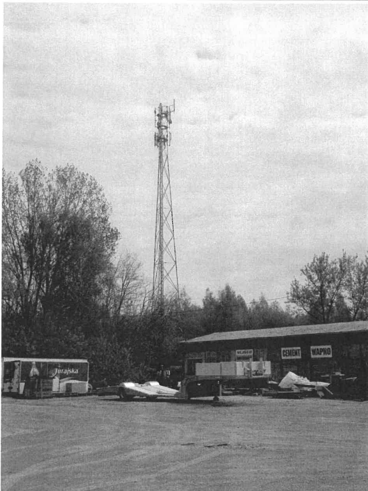
Załącznik nr 3 Instalacja Radiokomunikacyjna Orange Polska S.A. 3233 (89971NI) D14 TUMIDAJ (WSR_BRZEZNO_BRZEZNO) Dokumentacja fotograficzna
